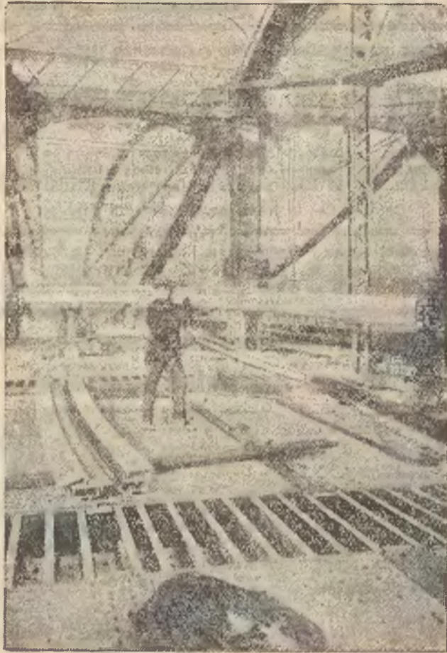
Koło Pittsburga w Stanach Zjednoczonych kończy się obecnie budowa mostu, którego wszystkie części składowe są z aluminium. Na zdjęciu widzimy jak robotnik dźwiga „olbrzymią“ lecz lekką belkę.
