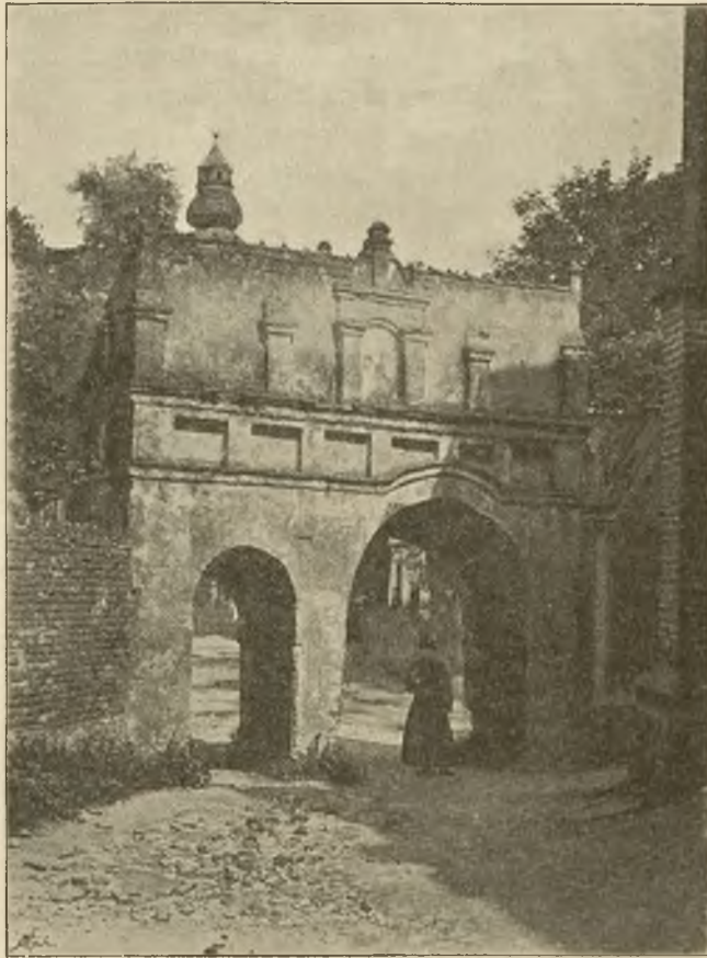
Fig. 43. Biecz. Brama obejścia kościoła parafialnego, widziana od strony kościoła. (Z fotografii).
