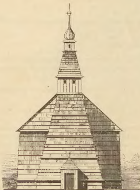
Fig. 64. Rozembark. Fasada kościoła paraf. drewnianego z r. 1756.
