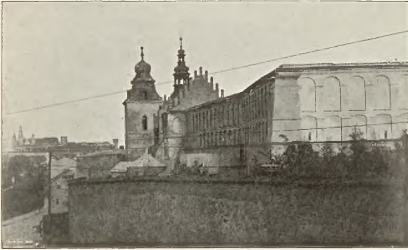
Fig. 197. Widok północno-zachodniego narożnika klasztoru PP. Norbertanek.
