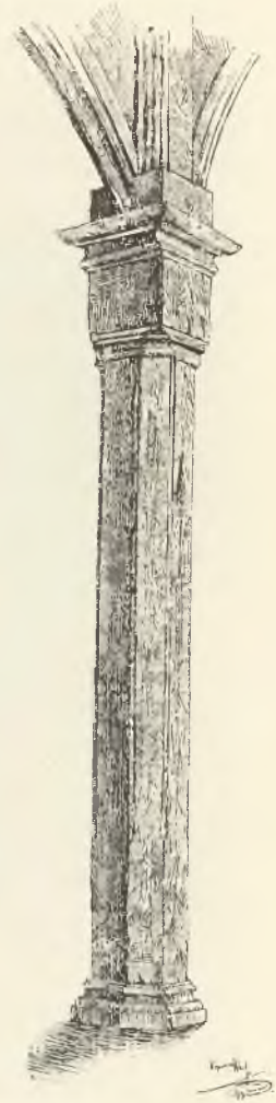
Fig. 87. Mogiła. Widok słupa drewnianego w kościele paraf.
