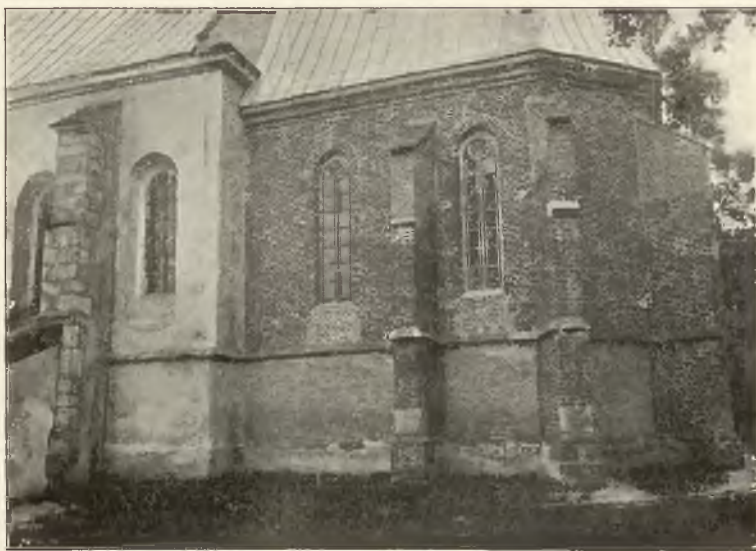
Fig. 33. Bolechowice. Widok zewnętrzny prezbiterium.
