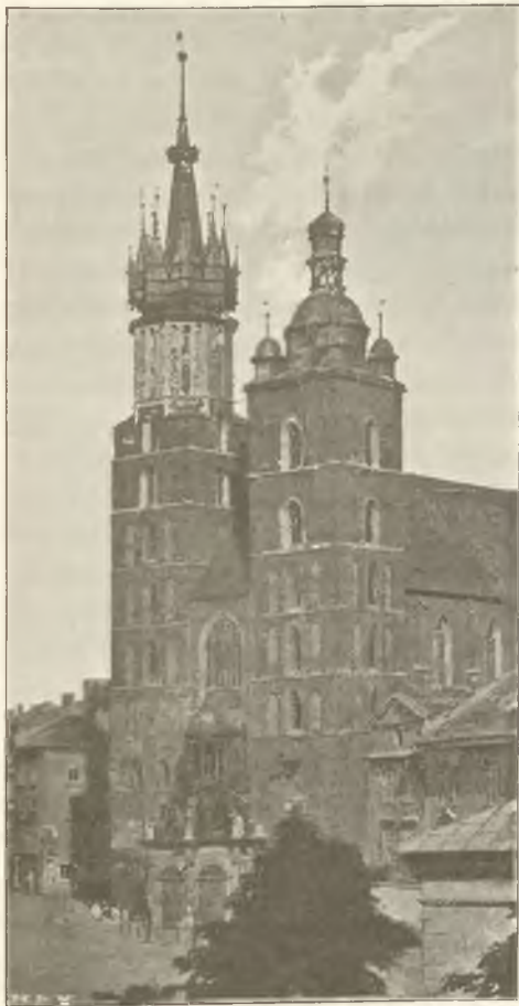
Fig. 1. Widok fasady zachodniej kościoła Maryackiego.
