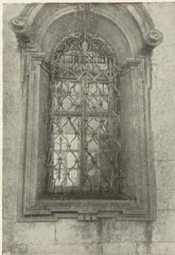
Fig. 11. Bielany. Okno dolne w fasadzie wieży.
