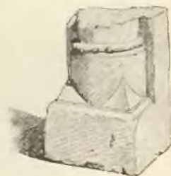
Fig. 1. Balice. Fragment w murze piwnicy pałacu.
