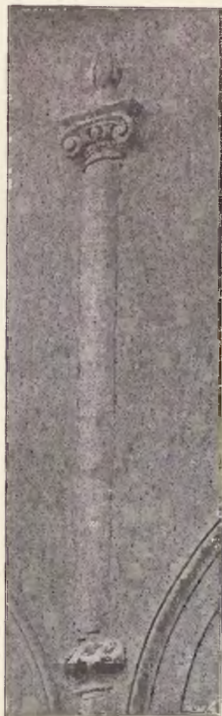
Fig. 44. Kolumna najwyższa i połączenie z kolumną dolną krużganku II piętra. Skrzydło zachodnie. Obie stoją wprost nad kapitelem poprzednim. Budowa Franciszka Lori.
