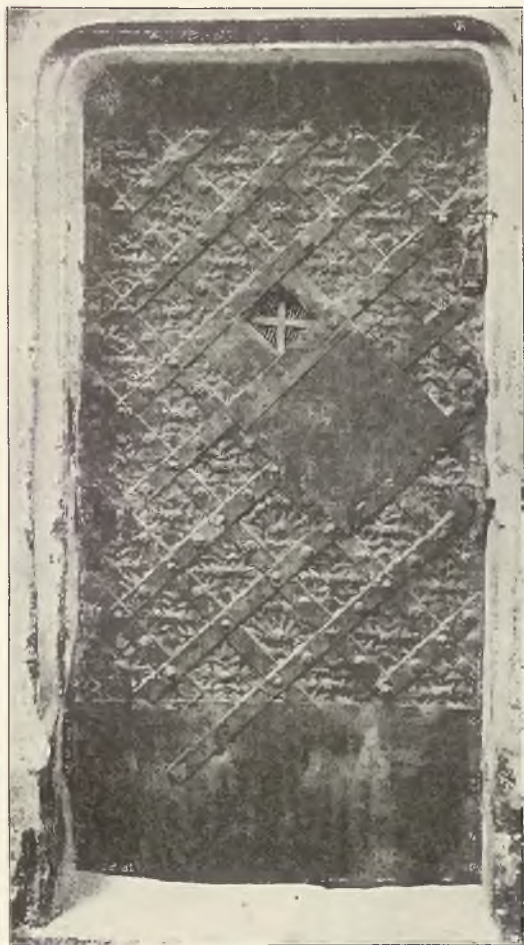
Fig. 94. Żelazne okucie drzwi do sklepu »Belek« na parterze zachodniego ramienia krużganków.
