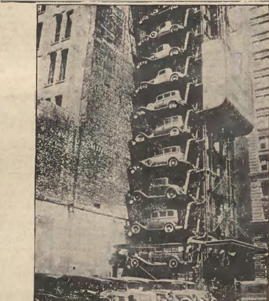
W Chicago zbudowano nowoczesny garaż samochodowy, w którym może się pomieścić 480 wozów. Samochody ustawia się jeden nad drugim za pomocą elewatora.
