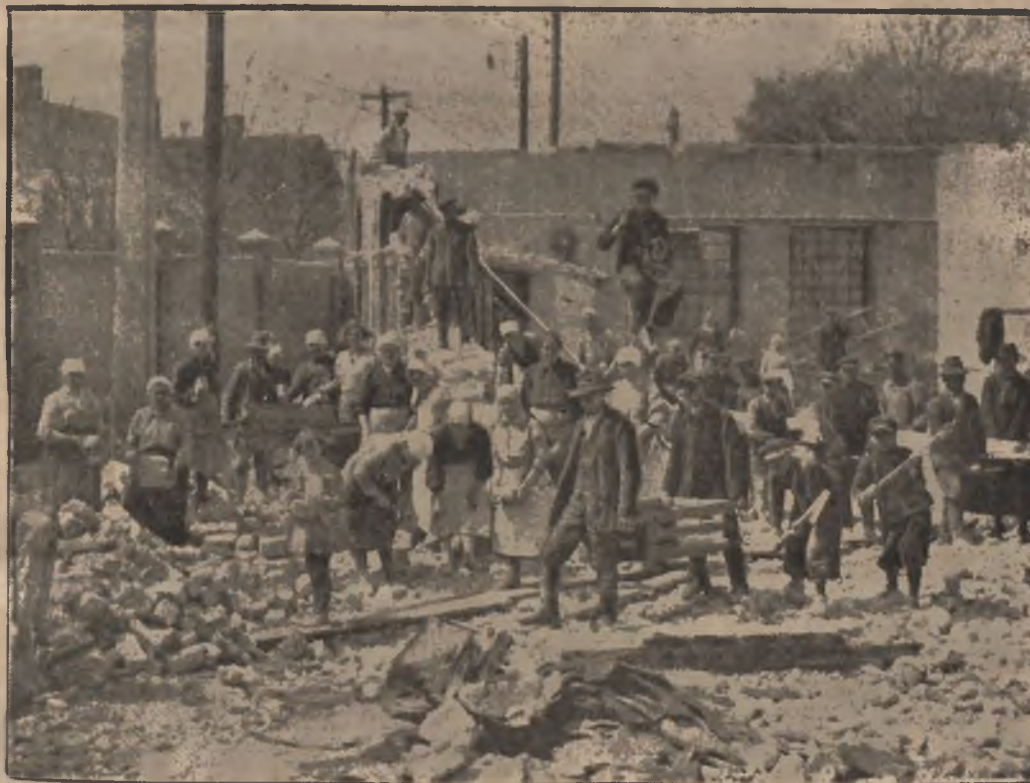
Budowa Domu Katolickiego w Będzinie.
