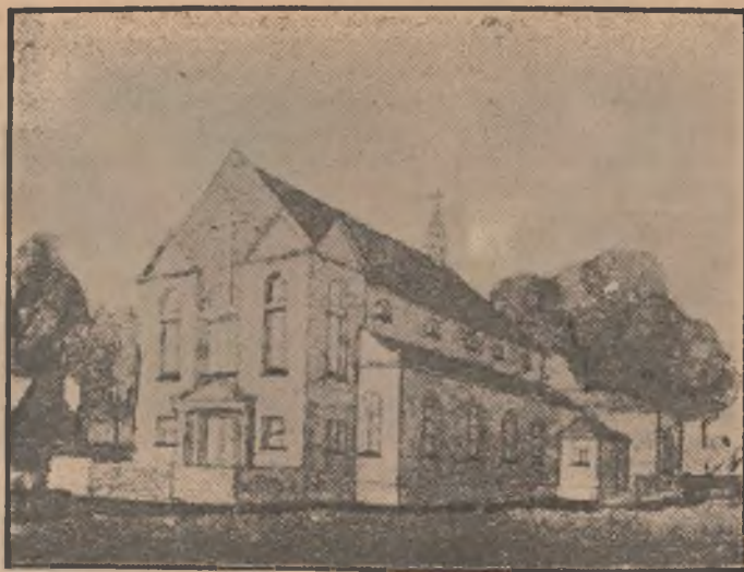
Parafia Cykarzew buduje nowy kościół. Oto widok przyszłego kościoła, którego mury wyciągnięte są już pod dach.
