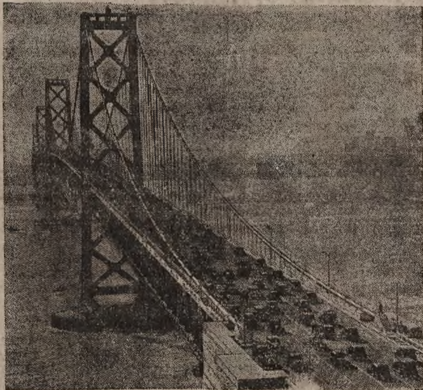
Ruch samochodowy na moście, łączącym San Francisco z miejscowością Oakland. Most ten został niedawno wybudowany i oddany do użytku publicznego.
