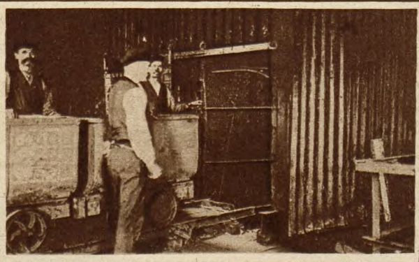
Kopalnia „Król“ w Królewskiej Hucie : Wydobyty węgiel przewozi się kolejką odziemną elektryczną pod wyciąg, który prowadzi go na powierzchnię.
