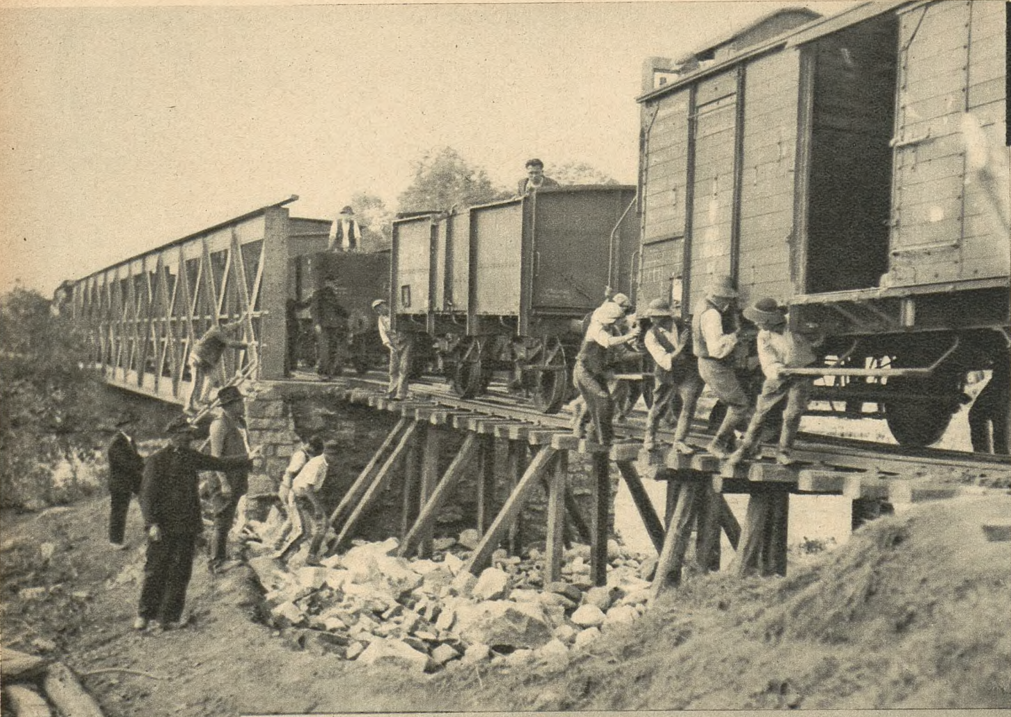
Przetaczanie wozu po uszkodzonym torze w Poroninie na linii Chabówka-Zakopane.
