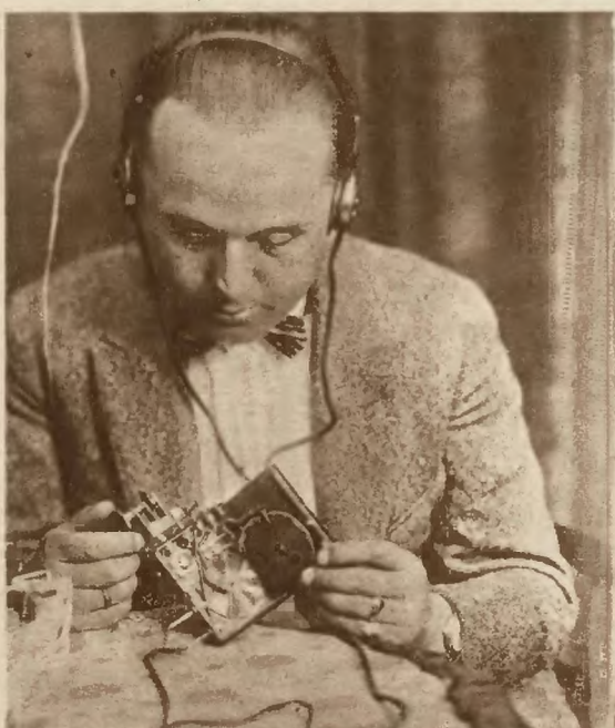
Radio w papierosnicy: Miniaturowy aparat, pozwalający na odbieranie fal głosowych w promieniu 40 km. Atlantic.
