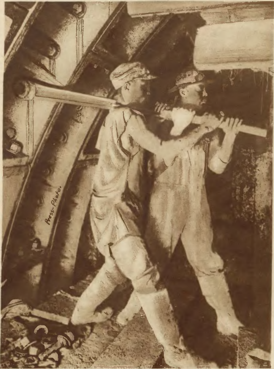
Fragment z budowy tunelu pod rzeką Hudson. Robotnicy przykręcają olbrzymie śruby.
