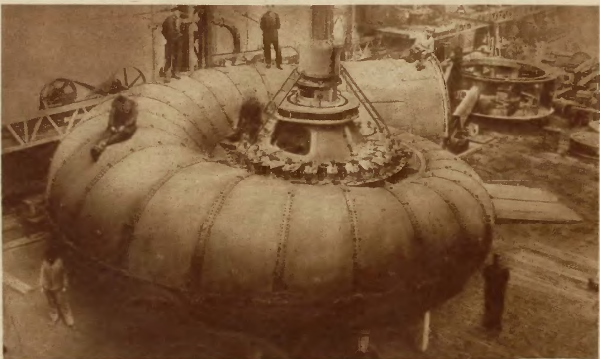
Na zamówienie japońskie wykonała jedna z fabryk niemieckich olbrzymią turbinę, której słup wody o wysokości przeszło 4 metrów wpływa do turbiny kształtu ślimaka, skąd na kilkunasto-metrową wysokość wytryska i obraca koło. Turbina ta przewyższa rozmiarami największe dotychczas turbiny wodospadów Niagara w Kanadzie.
