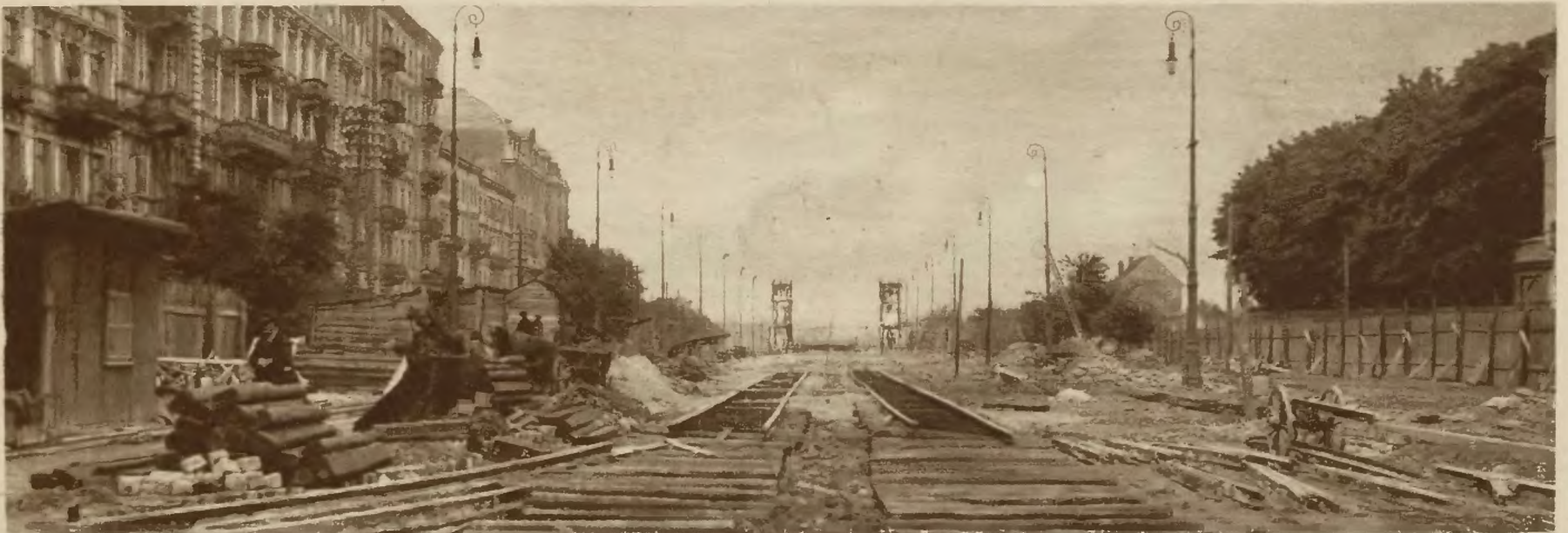
Nasze zdjęcie przedstawia widok na most Poniatowskiego z ul. Nowy Świat, poprzez Aleje 3-go Maja. Stan robót na tym odcinku pozwolił już Dyrekcji tramwajów miejskich w Warszawie na układanie toru tramwajowego, łączącego Pragę z Warszawą. Ag. fot. „Światowida”.
