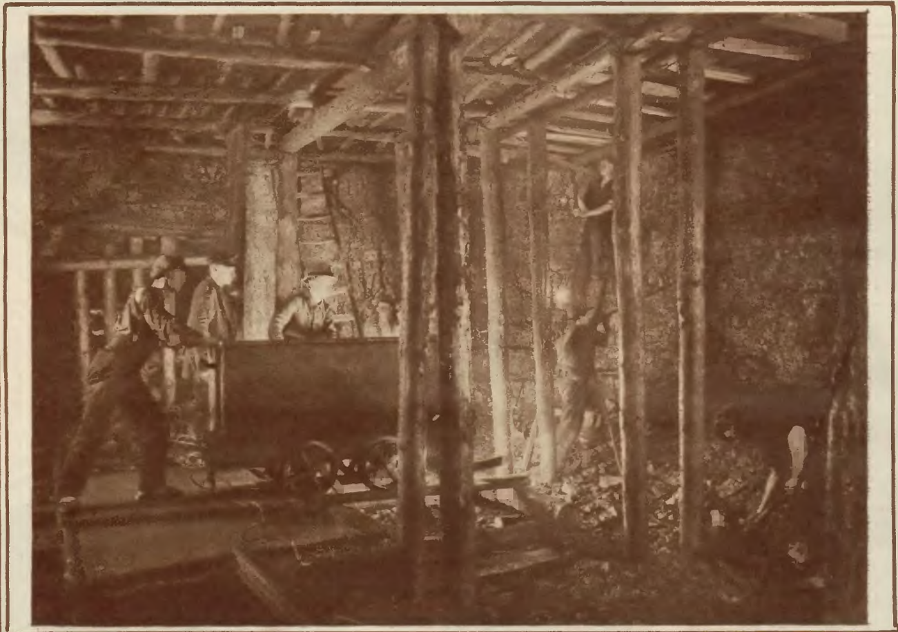
Praca w podziemiach kopalni „czarnych djamentów”; odbijanie kawałów węgla, przewożonych następnie wózkami, w szybie, podpartym belkowaniem.
