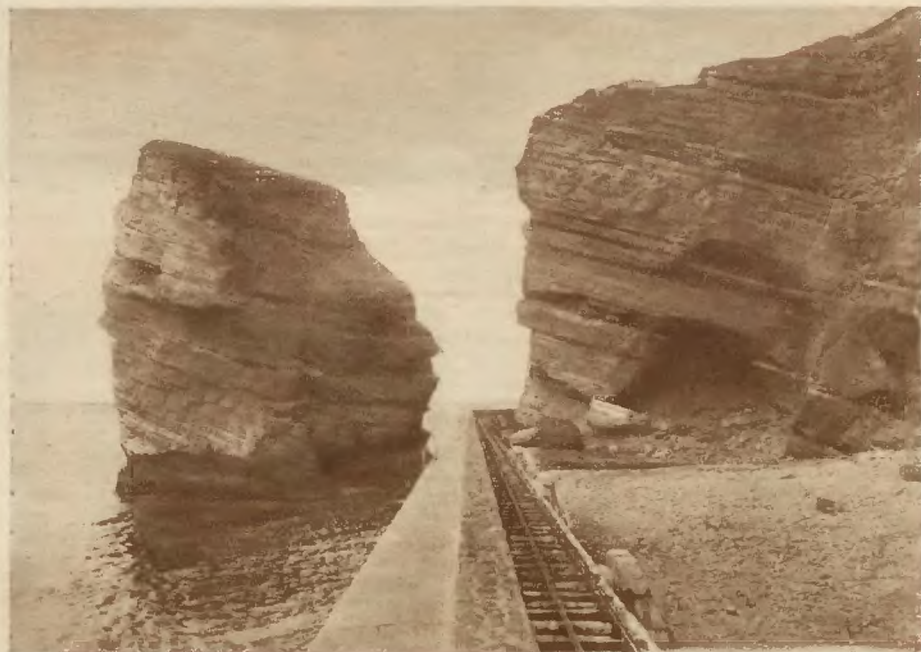
Walka morza z wyspą. Wyspa Helgoland, położona na morzu Północnym, w pobliżu Niemiec, ulega w ostatnich czasach powolnemu odrywaniu skalistych wybrzeży przez fale morskie. Dla powstrzymania tego zniszczenia otacza się obecnie wybrzeże wyspy masywnym murem, którego część w pobliżu oderwanego już bloku skalistego przedstawia nasze zdjęcie.
