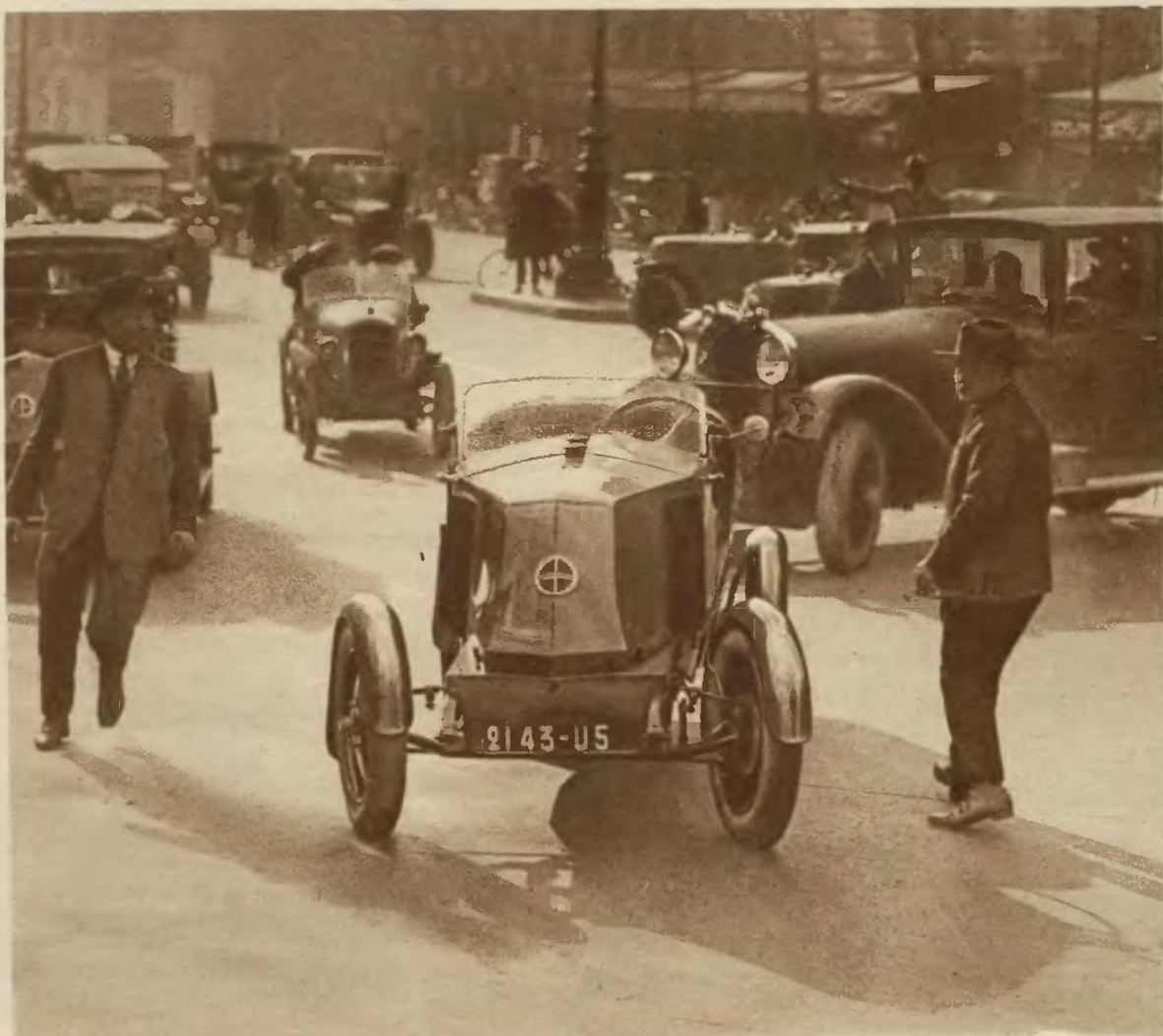
Niebywałą sensację wywołał na wielkich bulwarach paryskich samochód bez szofera, kursujący wśród tłoku innych wozów bez szkody dla siebie czy dla nich. Tajemniczą siłą, kierującą nim, był aparat iskrowy, umieszczony w jadącym za nim samochodzie i tam obsługiwany przez mechanika. Fot. Meurisse, Paryż.
