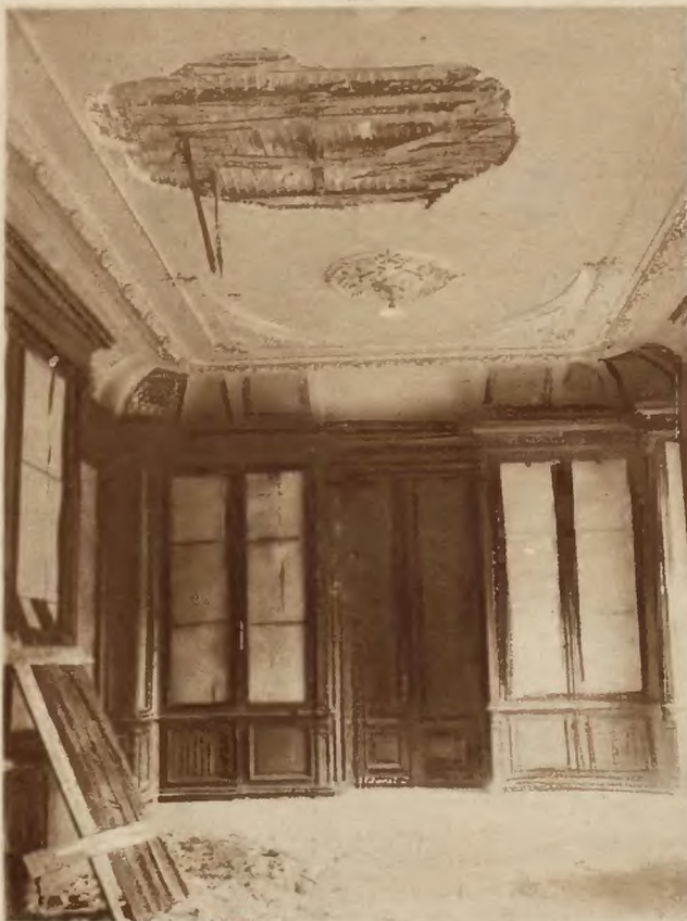
dratowych oberwał się i runął na gablotki i szafy, powodując zniszczenie i uszkodzenie wielu cennych obiektów. Na naszym zdjęciu na lewo podajemy front budynku muzealnego, na zdjęciu na prawo zaś widok sali, gdzie katastrofa miała miejsce (po natychmiastowym opóźnieniu jej z przedmiotów muzealnych).
