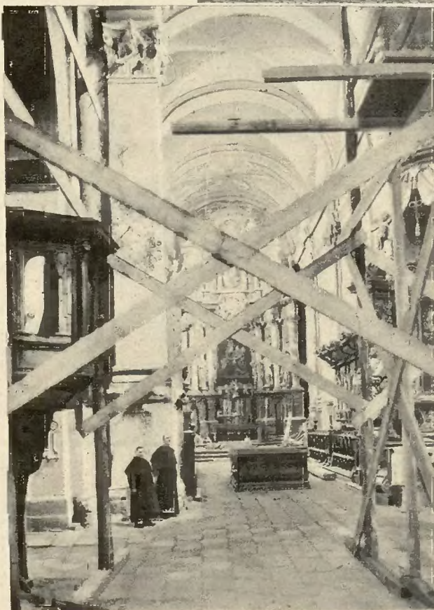
Restauracja kościoła. Widok głównej nawy z rusztowaniem dla odnowienia głównych części ścian i sklepienia.
