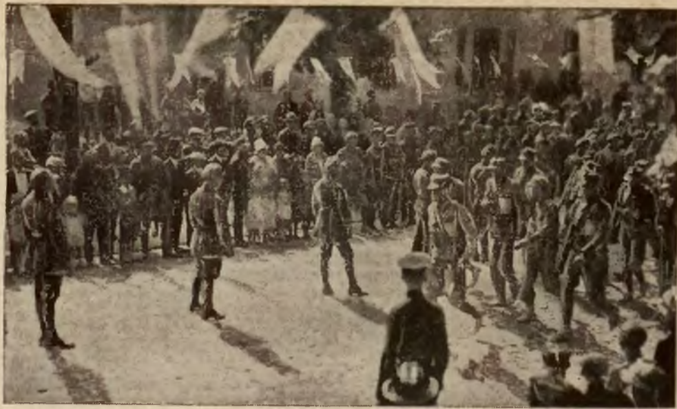
Ag. fot. „Światowida” na płytach kraj. „Alfa”.
