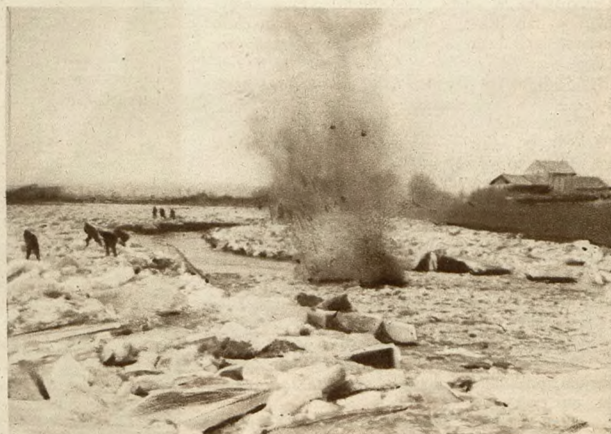
Rozbijanie lodów na rzece Prut. Aby uchronić okolice powiatu kołomyjskiego od wiosennego wylewu rzeki Prut pluton pionierów 49 p. p. przystąpił do akcji przeciw lodowej, z której tutaj podajemy ciekawy moment, a mianowicie moment wybuchu min, założonych celem utworzenia kanału.
