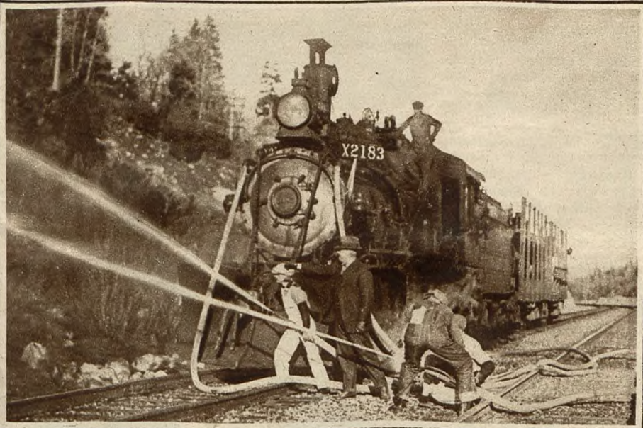
Gaszenie pożarów lasów w Ameryce. Wobec grozy często zdarzających się na stepach amerykańskich olbrzymich pożarów lasów skonstruowano tam osobny rodzaj pociągów kolejowych pożarniczych, wiozących z sobą rezerwoary wodne i sikawki, służące do gaszenia ognia.
