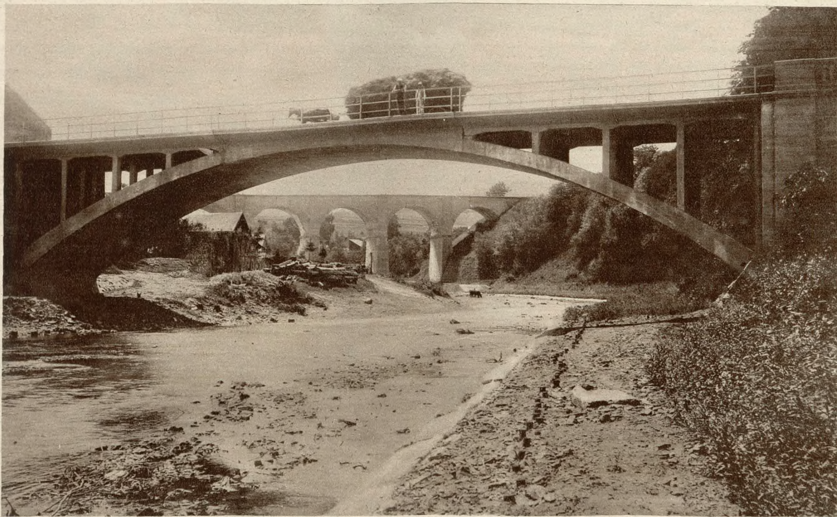
Nowy most w Grybowie. Na rzece Białej w Grybowie stanął wspaniały most łukowy z żelazo-betonu, o rozpiętości 36 m. w świetle, wybudowany przez Krak. Okręgową Dyрекcję Robót Publicznych we własnym zarządzie. Budową pięknego mostu, który reprodukowujemy, kierował inż. Franciszek Milan.
