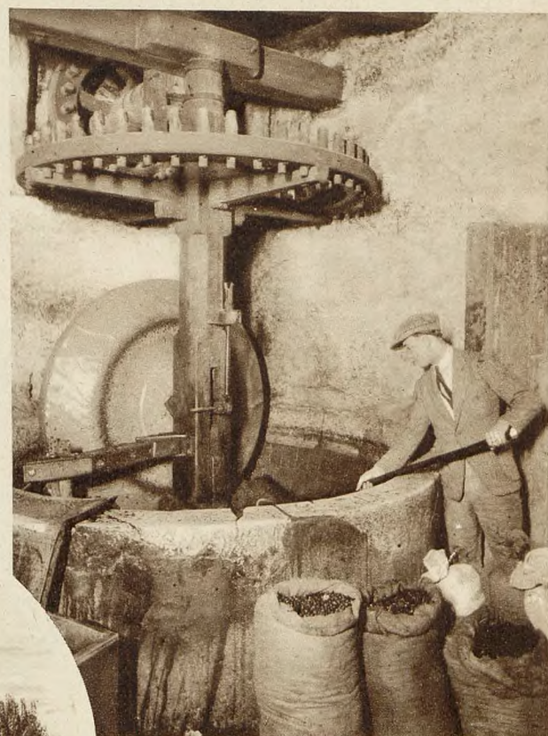
Młyn starego systemu, w którym dla otrzymania większej masy oliwy kosztem jej jakości miele się oliwki z pestkami.
