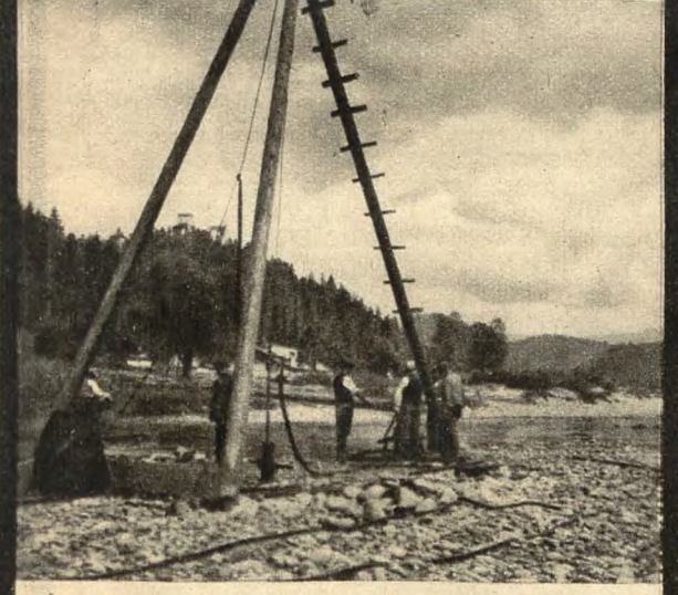
Świder, przy pomocy którego prowadzone są badania geologiczne na pograniczu Czorsztyń i Niedzicy.
