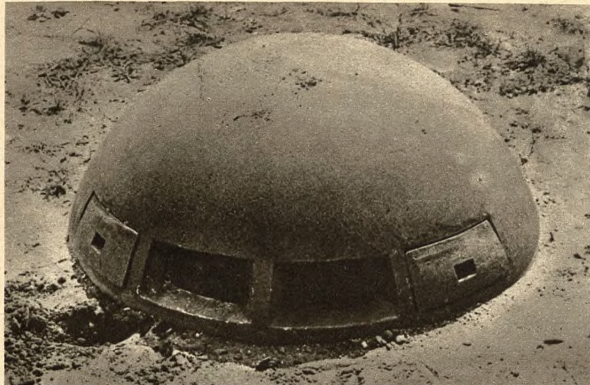
Na lewo: Wieża pancerno-betonowa z linii Zygfryda, wzorowana na francuskiej.
