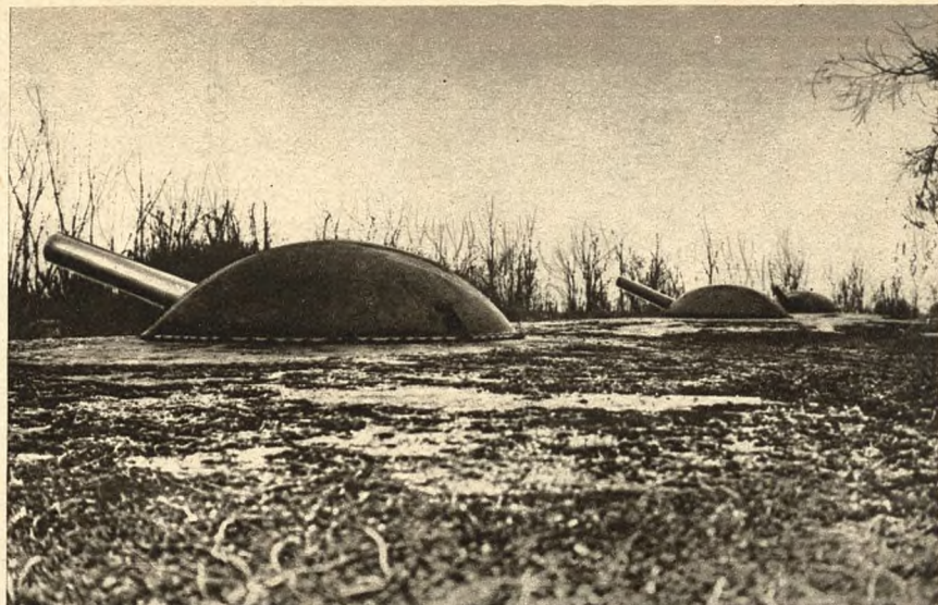
Na lewo: Wieża pancerno-betonowa z linii Zygfryda, wzorowana na francuskiej.
