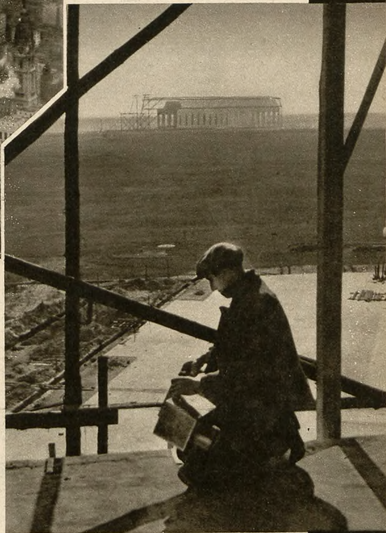
Ostatnie prace na nowym lotnisku pod Frankfurtem: lakierowanie żelaznej konstrukcji gmachu dyrekcji.
