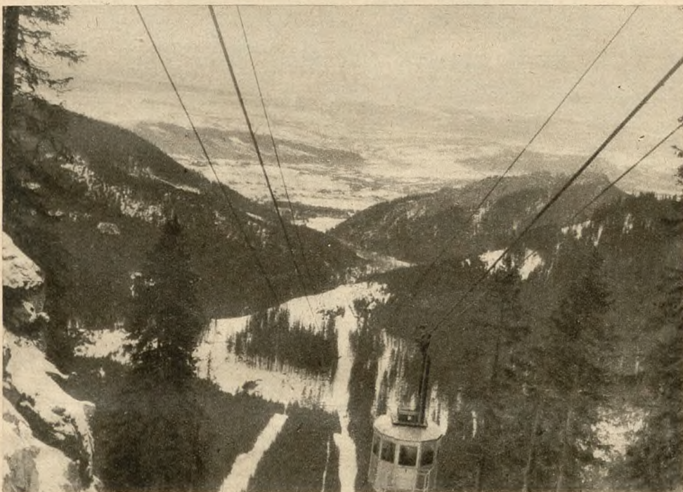
Wagonik zbliżający się od trzeciej podpory do Myślenickich Turni. Odcinek ten ma długości 997 m, przy najwyższem wzniesieniu nad ziemią 135 m. W dali widać Zakopane i Dolinę Nowotarską.
