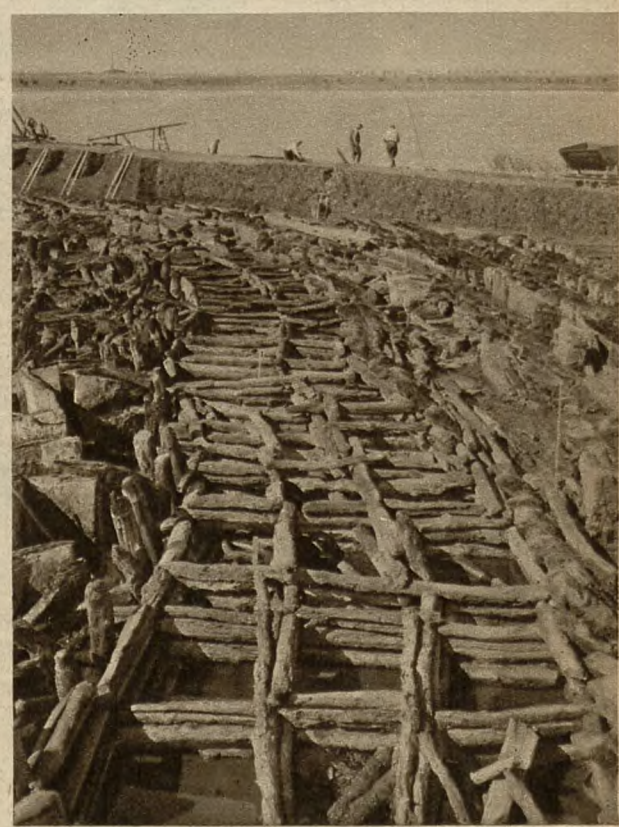
Wał obronny, ołączający gród w Biskupinie, zbudowany z dragów dębowych, tworzących skrzynie-izbice, wypełnione piaskiem.
