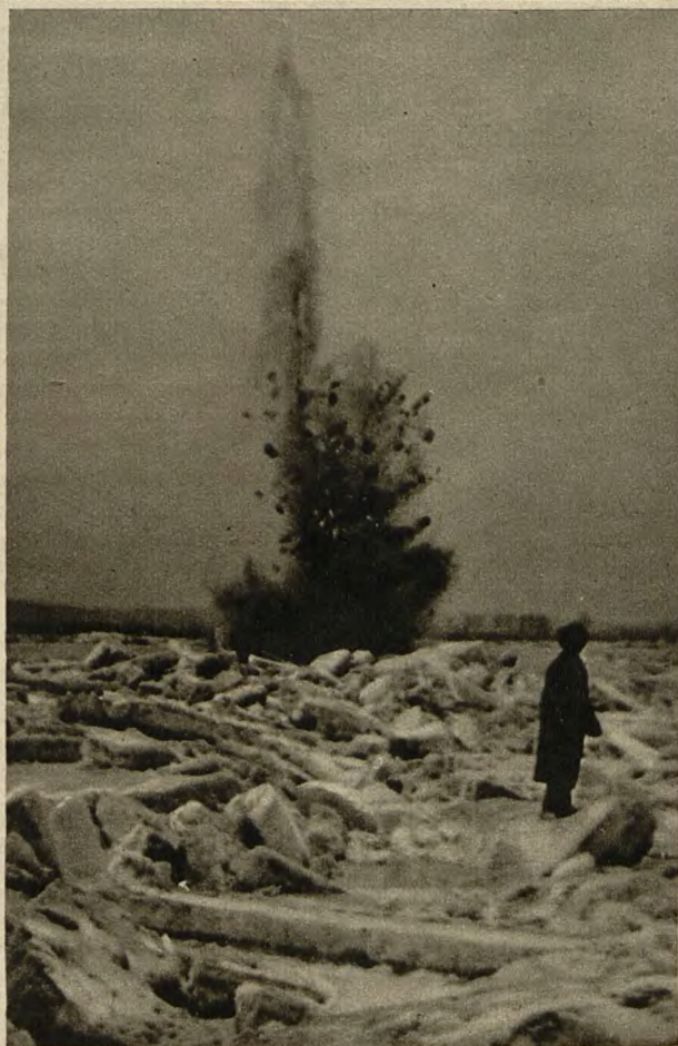
Wysadzanie przy pomocy min zatoru lodowego pod Fordonem.
