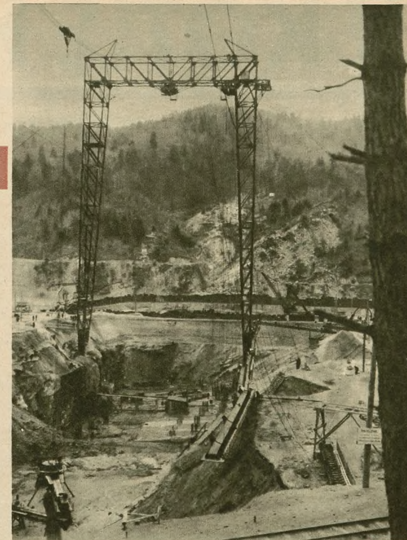
Wykop w miejscu, w którym stanie zapora. Nad wykopem widoczna żelazna rama, na której umocowane są liny kolejki linowej i transporterów taśmowych.
