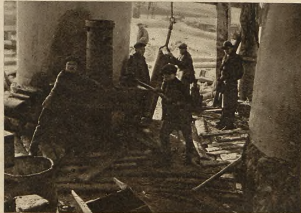
Roboty ratownicze, poprzedzające wtłaczanie pali żelbetonowych.
