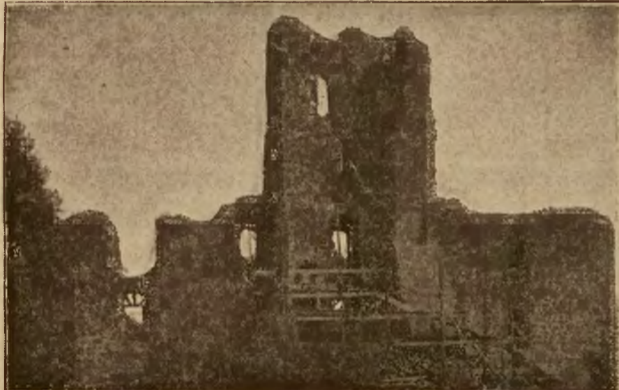
Ruiny Zamku na wyspie. — Wieża wjazdowa
