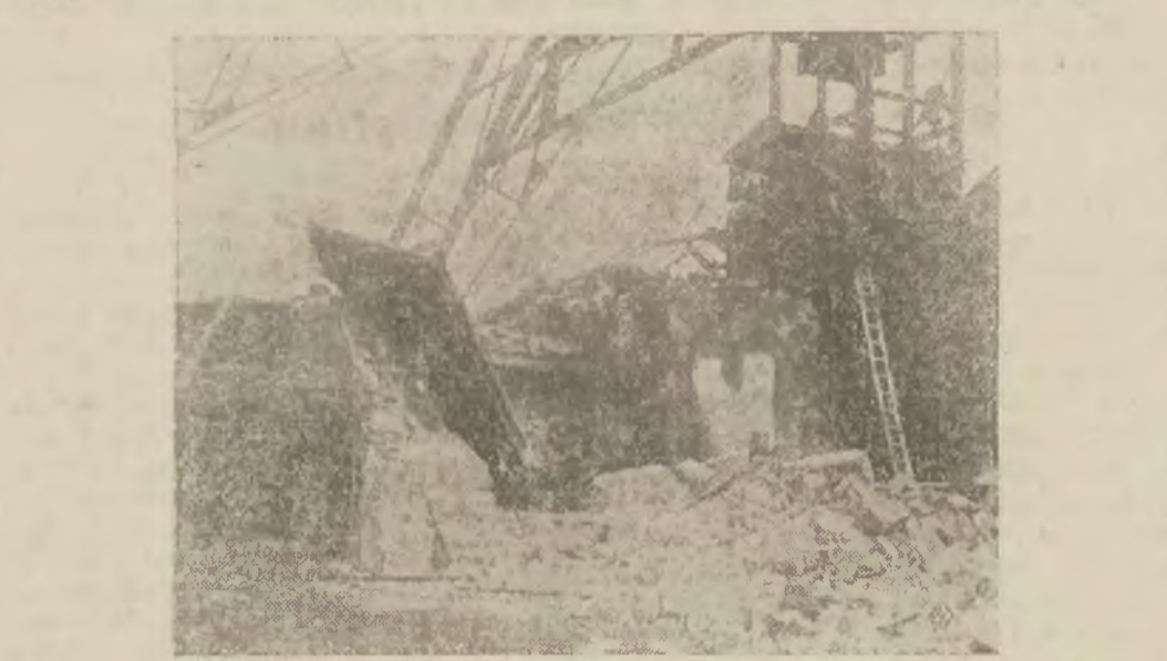
Zburzona wskutek eksplozji wieża wyciągowa na szybie Nelson III, w kopalni węgla brunatnego pod Ossekiem...
