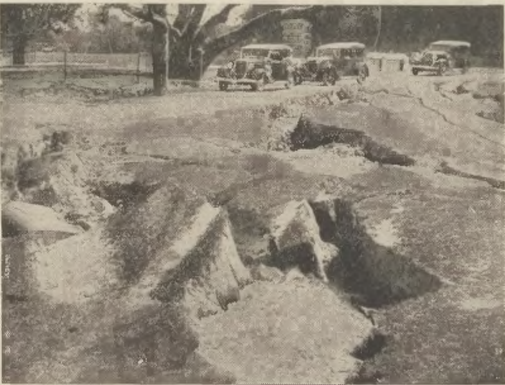
Zdjęcie z poprzedniego trzęsienia ziemi w mieście Muzalfarpur. Okolice te nawiedziło ostatnio ponowne trzęsienie ziemi trwające zaledwie jedną minutę. Wystarczyło to by dawne pęknięcia ziemi potworzyły się na nowo. Wiele domów zostało zupełnie zniszczonych a ich mieszkańcy stracili dach nad głową.
