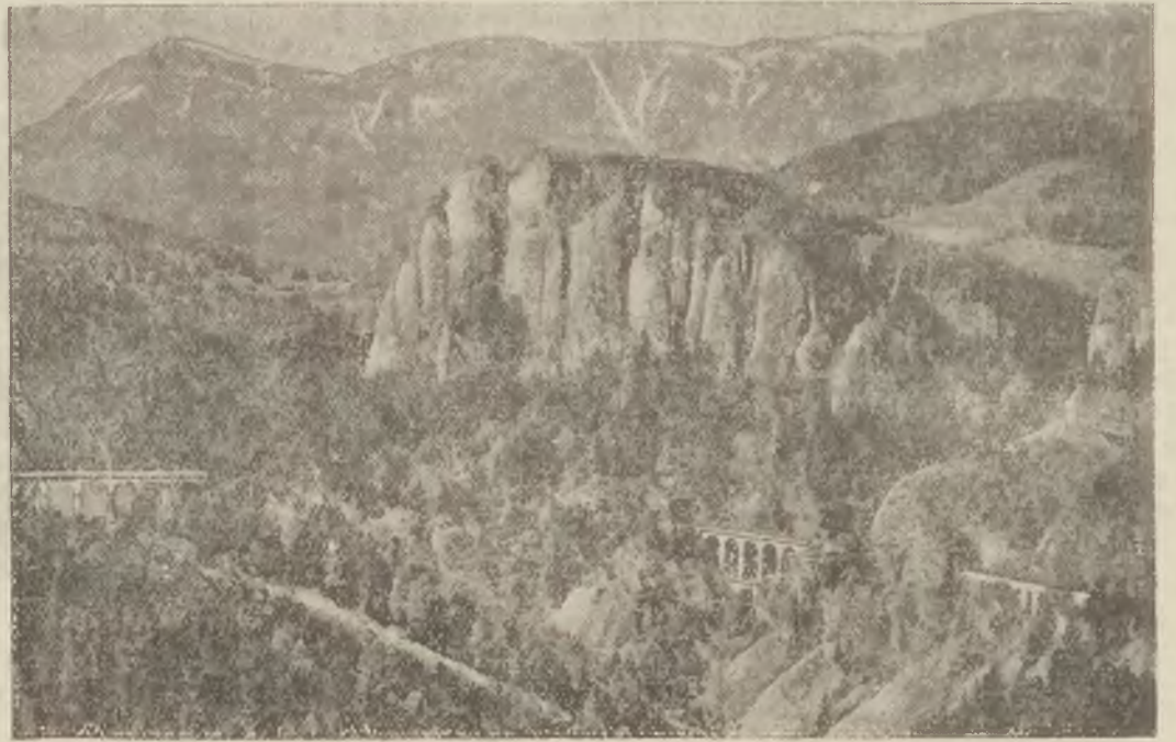
Linja kolejowa na Semmeringu, z jej wiaduktami i tunelami. W tem miejscu wykonano zamach bombowy, który uszkodził tunel i tor, wskutek czego ruch jest narazie przerwany. Zamach ten, to tylko jedno ogniwo w łańcuchu dziesięciu zamachów, wykonanych w Austrii w ciągu 24 godzin przez grupy terrorystyczne
