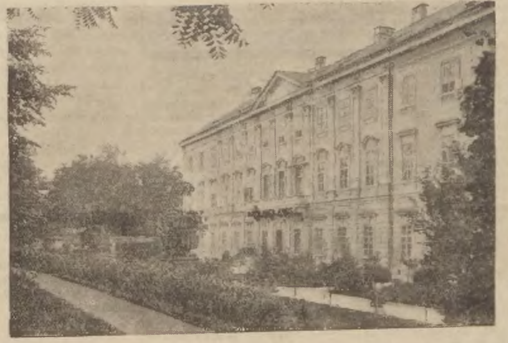
Słynny zamek Mirabell koło Salzburga, należący do najwspanialszych budowli barokowych, został odnowiony i będzie odtąd służył jako kasyno do gry.
