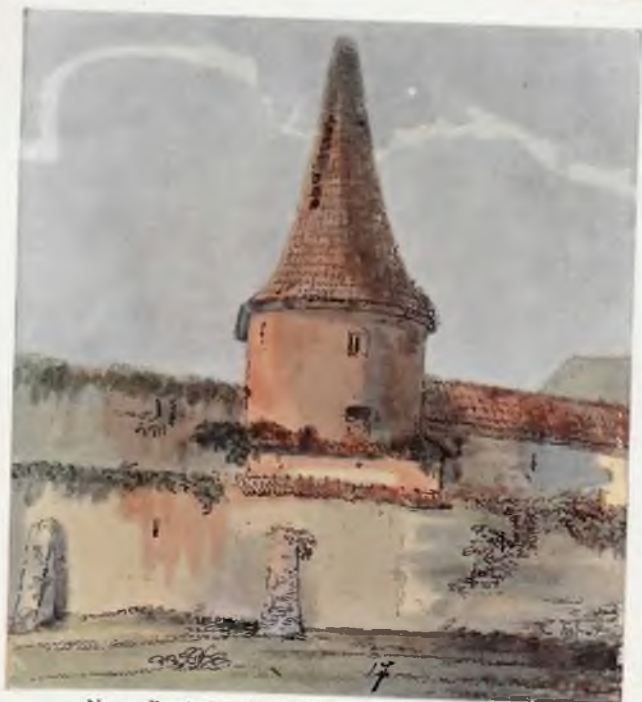
Nr. 3. Baszta introligatorów. — La tour des relieurs.
