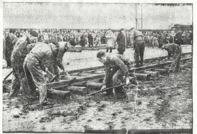
Ćwiczenia drużyn K. P. W. w układaniu toru kolejowego.
