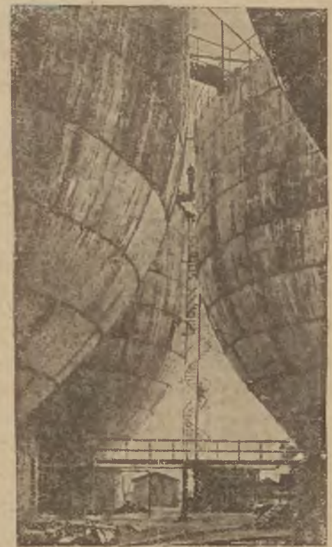
Budowa zbiorników gazowych w Hamburgu.
