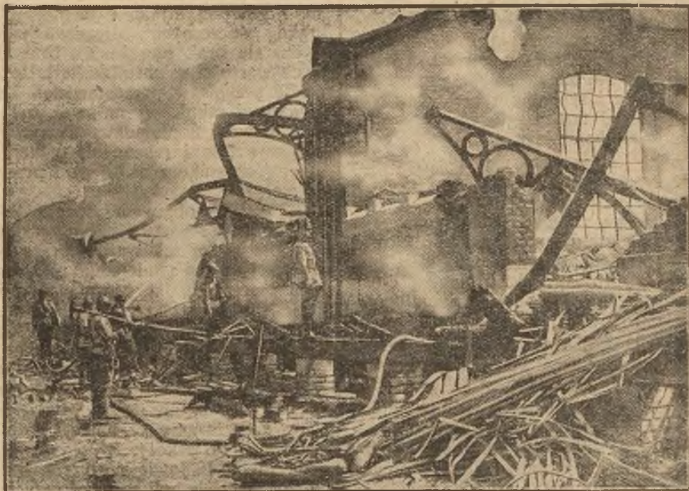
Gmach ten spłonął doszczętnie, a szkody przez pożar wyrządzone, obliczają na 200 milionów leji (ponad 10 milionów złotych). Zachodzi podejrzenie, że ogień podłożyli urzędnicy celni, aby zniszczyć ślady popełnionych nadużyć.
