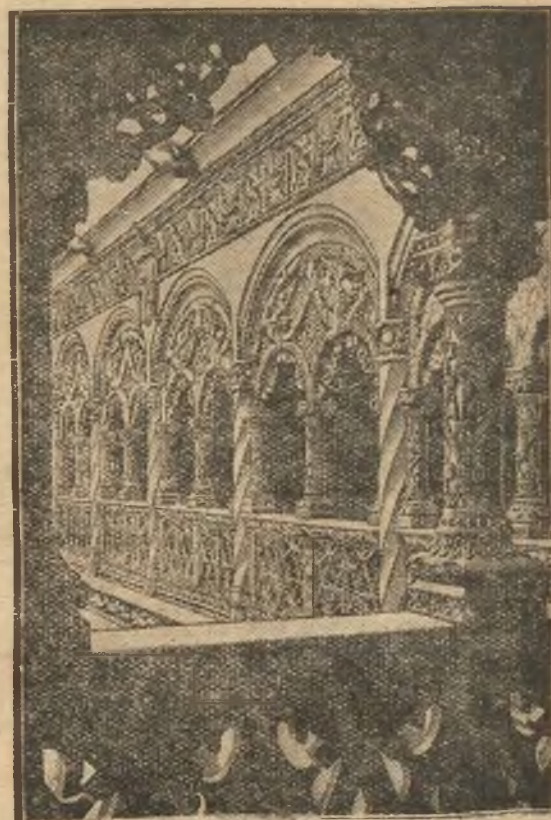
Wspaniała fasada klasztoru Dominikanów San Gregoria w Valladolid (Hiszpanja).
