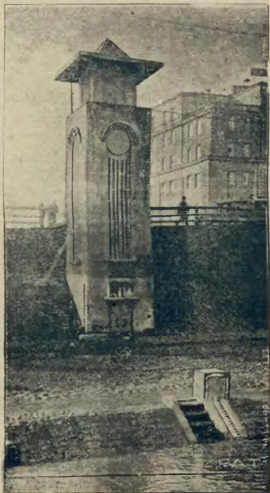
Wodowskaz, notujący poziom wody, został ustawiony nad brzegiem Wisły przy moście Kierbedzia.
