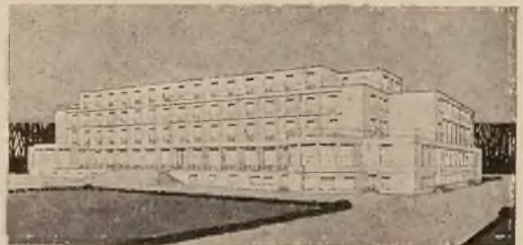
Dom Zdrojowy (w budowie na ukończeniu).
