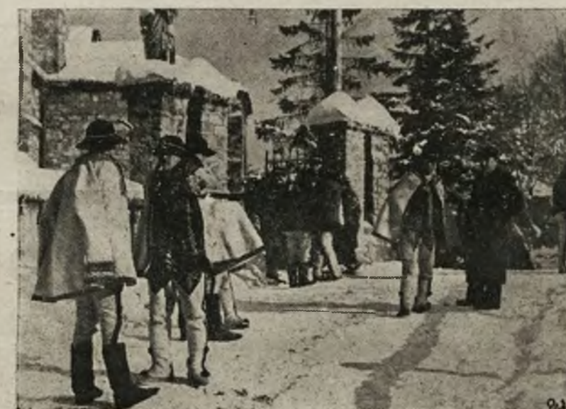
W niedzielne popołudnie przed kościołem w Zakopanem.
