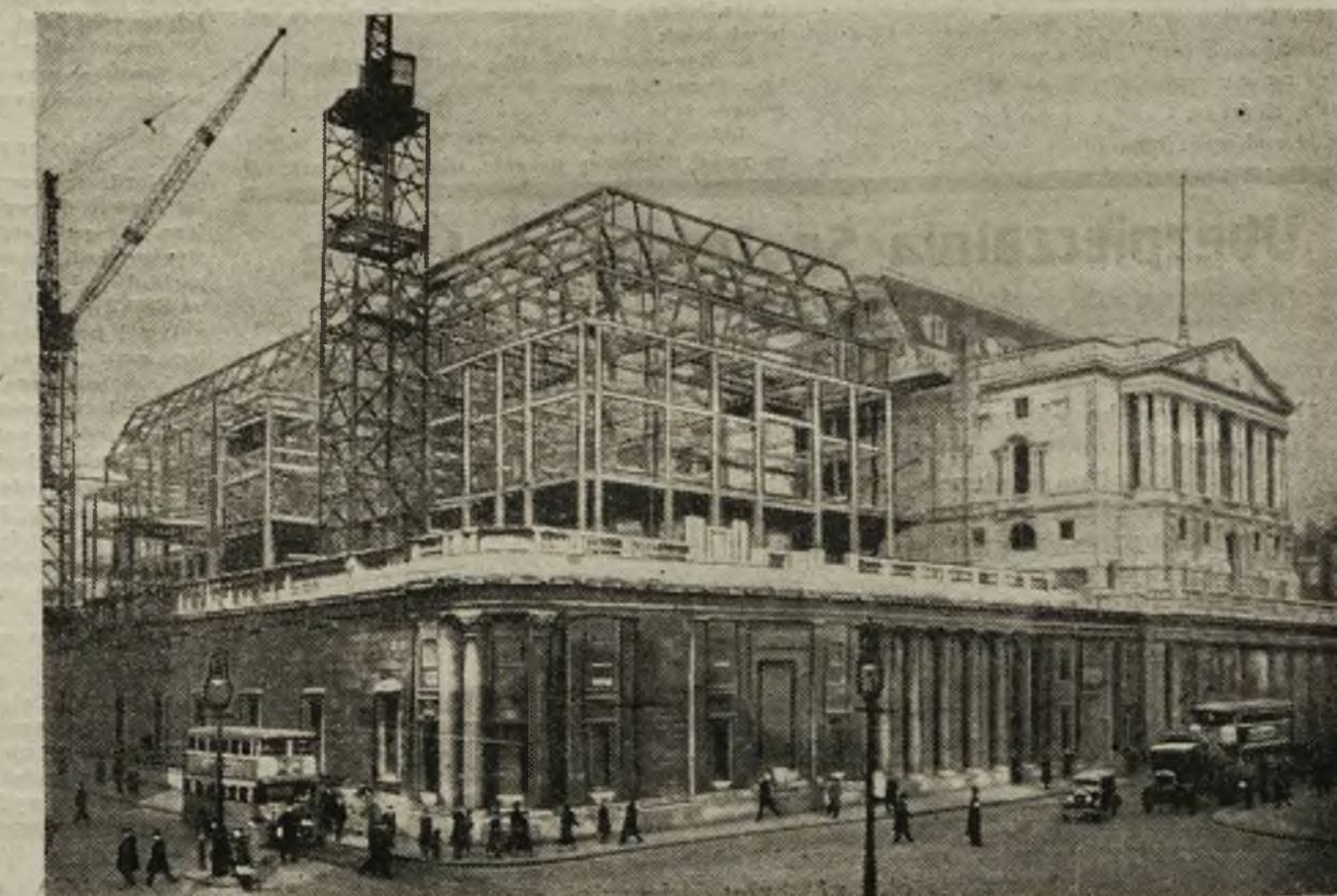
Przebudowa gmachu banku angielskiego. Przebudowa gmachu banku angielskiego, która przez dłuższy czas była przedmiotem inapaści ze stromych pewnych ugrupowań, postępuje naprzód. Ilustracja przedstawia stan robót nad przebudową gmachu.
