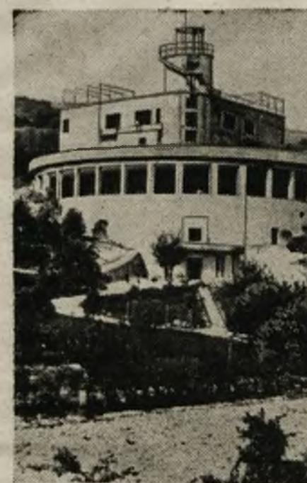
Dom w słońcu. Pewien włoski inżynier w pobliżu Werony zbudował dom, w którym od rana do wieczora promienie słoneczne zaglądają do okien. Umożliwia to specjalny motor, który górne piętra domu obraca do słońca jednocześnie z obrotem tarczy słonecznej.
