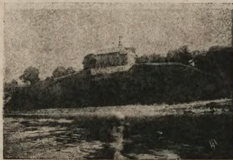
Widok od strony Niemna na Kolozé, świątynię bazylikańską z XI wieku, najstarszą na wschodnich rubieżach Polski. Połowa budynku runęła do Niemna w XIX w. skutkiem podmycia. Obecnie świątynia znajduje się w rękach prawosławnych.
