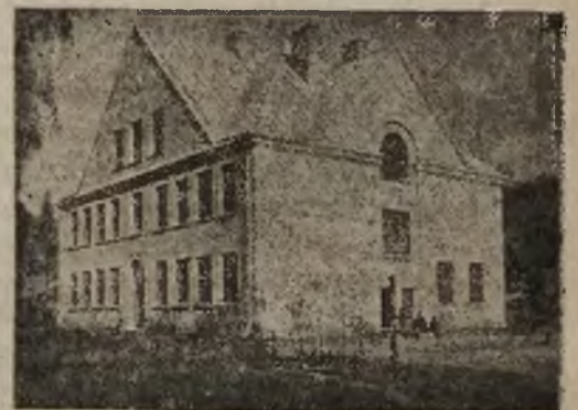
7-klasowa Publ. Szkoła Powszechna w Bieniakoniach. Budowę Szkoły zaczęto w r. 1929, mogła być jednak wykonana dopiero przy pomocy Towarzystwa P. B. P. S. P. Oddano ją do użytku 20 sierpnia 1934 roku.
