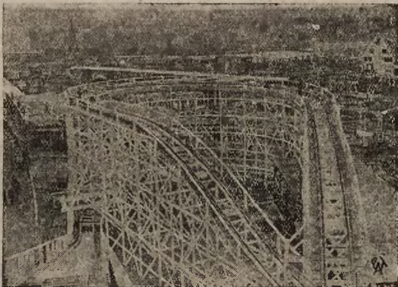
Olbrzymie rusztowania przy budowie „Djabelskiej Kolejki” w parku atrakcyj na Wystawie Międzynarodowej w Brukseli.
