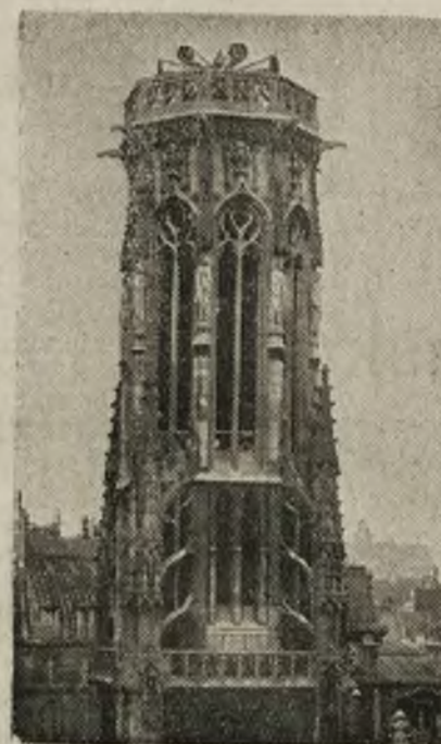
Paryż broni się. W celu obrony przed atakami lotniczymi na wyższych budynkach w Paryżu zostały ustawione syreny, któreby w wypadku ewentualnego najazdu samolotów nieprzyjacielskich ostrzegły ludność przed niebezpieczeństwem. Na zdjęciu — kościół Saint Germain l'Auxerrois z syrenami na wieży.
